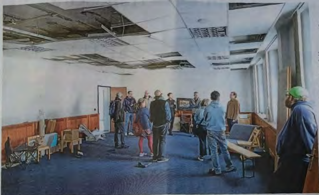
Bis aus den ehemaligen Büros der US-Army Wohnungen, Vereins- und Gewerberäume werden, ist noch viel zu tun. Insgesamt rechnet der Verein „Wohnso“ mit einem Investitionsvolumen von 9,5 Millionen Euro für Kauf und Sanierung. Fotos: Philipp Rothe
