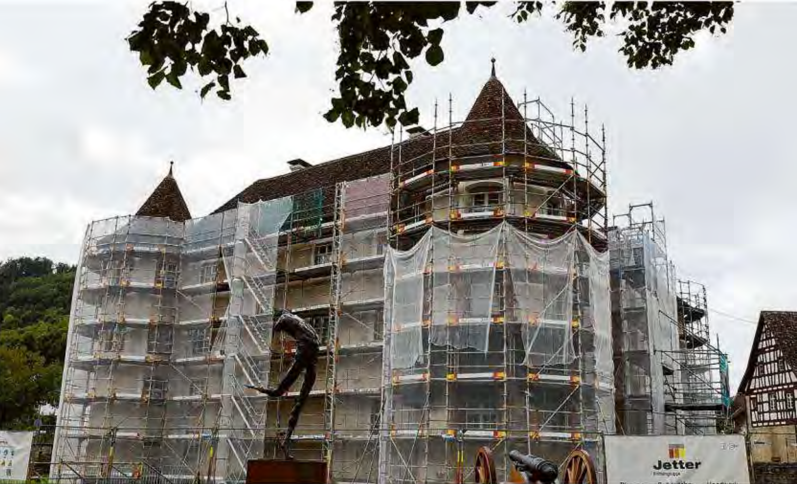
Das Wasserschloss ist immer noch eingerüstet und eingehüllt.
