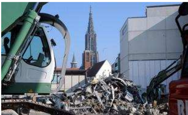
Abriss für die Sedelhofgalerie. (Foto: Andreas Brücken)
